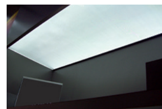
Éclairage par dalle LED totale gradable
