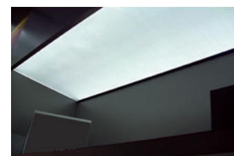
Éclairage par dalle LED totale gradable
